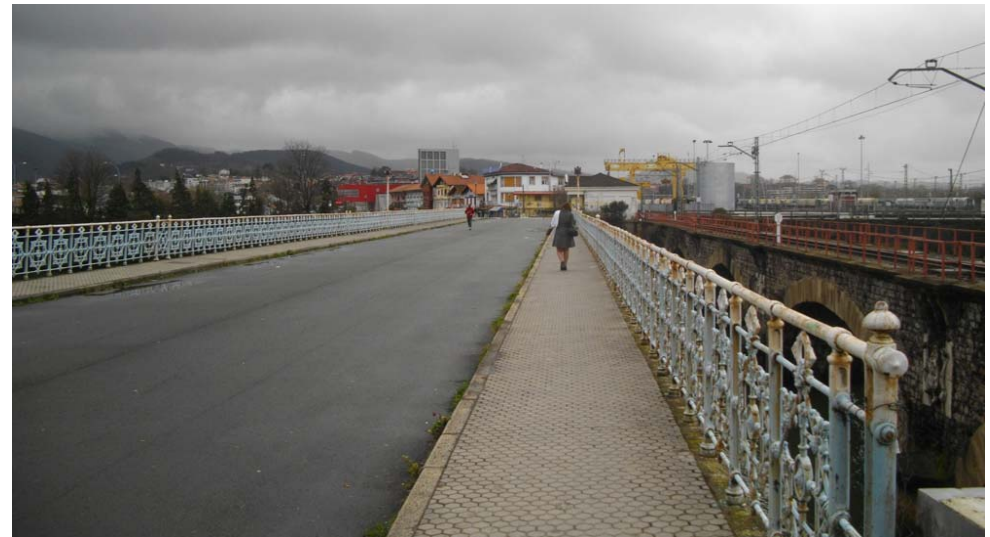
Puente peatonal sobre el Bidasoa entre Irún y Hendaye
