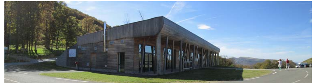
Nouvel espace d'accueil des Chalets d'Iraty
